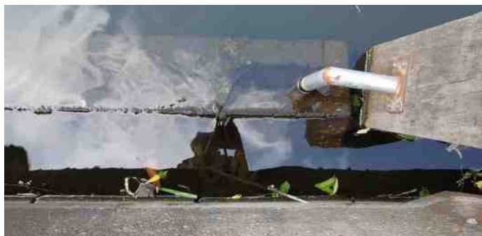
Balk, geleider en meerpaal in de Leidse Rijn
