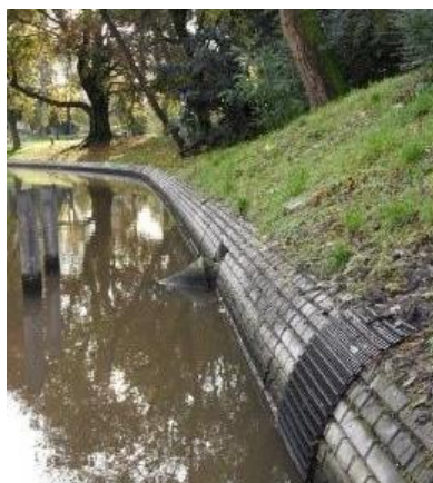
Detail betonnen rand foto: Paul van Kan
