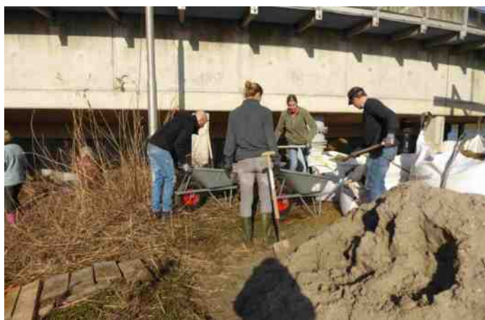
Aanleggen van de Ijvogelwanden
