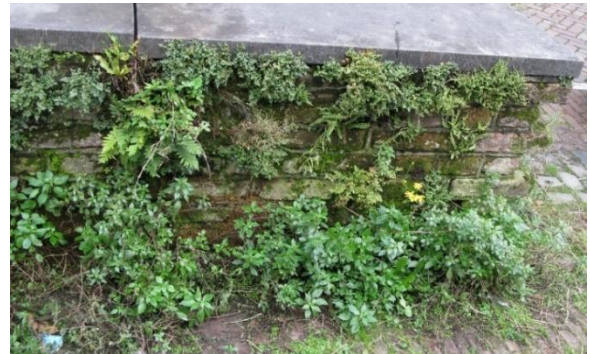
Afbeelding 22 Blok bij Gruttersdijk nr.8 waterkant 2019
