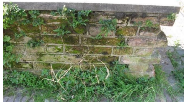
Afbeelding 23 Blok bij Gruttersdijk nr. 8 waterkant 2021
